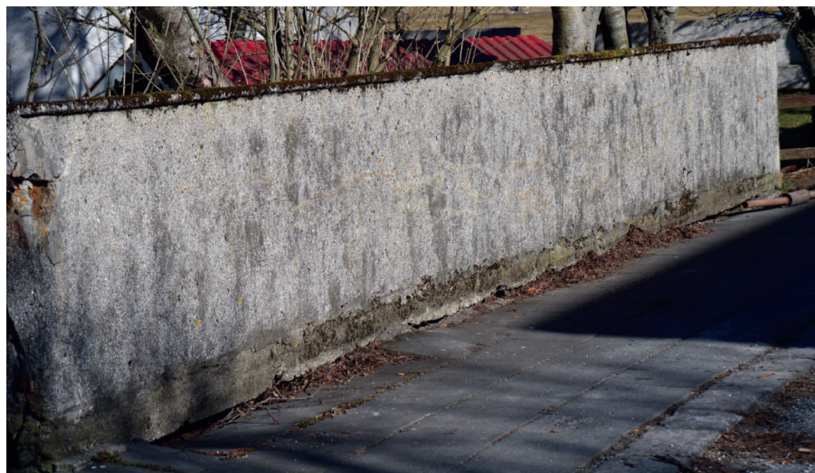
Mynd 9.13. Sig jarðvegs í kringum hús í Norðurmýri í Reykjavík vegna losunar kolefnis við framræslu jarðvegsins.
